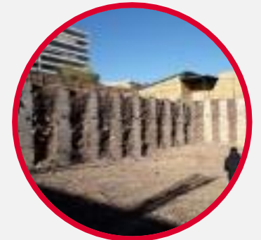
HABILITACIÓN DE TERRENOS Y PROYECTOS DE EXCAVACIÓN
